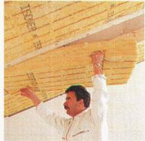
Nach dem Verlegen der FLAMMEX N-Folien sichern die Butylkautschuk-Bänder ISObutyl die Luftdichtigkeit zwischen den Bahnen und den übrigen Bauelementen.
