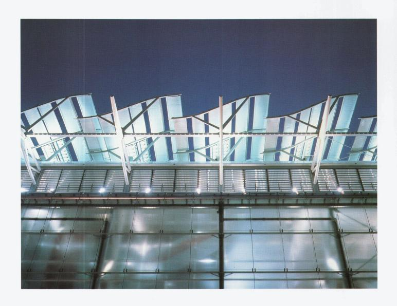
Detail Wasserfassade und Sonnensegel Façade à rideau d'eau et voile de protection solaire Detail of water façade and sun sail
