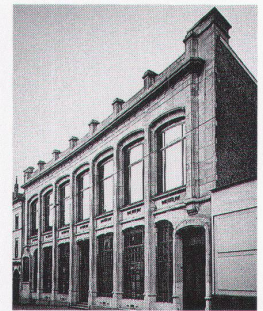
Victor Horta, Magasins Waucquez, 1903–1906 (heute das Centre belge de la bande dessinée [Belgisches Cartoon-Zentrum]) Die auf eine schmale Strasse gehende Fassade ist, ohne dass dies offensichtlich wäre, nach innen gekrümmt, um die Fassade auch aus steilem Blickwinkel sichtbar zu machen
