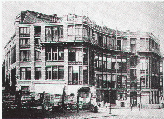
Victor Horta, Maison du Peuple, 1895 (démolie en 1964) Un programme trop chargé pour un terrain exigu; Horta «invente» la grande salle au dernier étage, en surplomb sur l'obligatoire cour intérieure et complète, côté rue, le tracé circulaire des alignements existants
