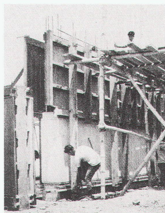
Montierte Schalungstafeln Les panneaux de coffrage montés Formwork panels, installed
