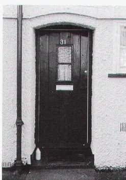
Neue und ursprüngliche Eingangstür an der Ridge Avenue Portes d'entrée nouvelle et originale sur Ridge Avenue New and original front doors in Ridge Avenue
