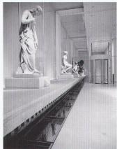
Glasstreifen im Fussboden des Foyers, von unten und von oben
