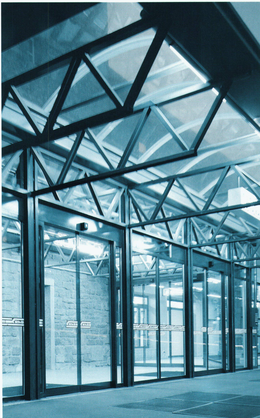
Bahnhof der Rhätischen Bahn, St. Moritz, Schweiz, Doppelschiebetür
