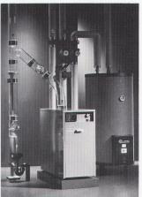
emissionen. Die Messwerte bei den neuen Low-NO<sub>x</sub>-Gasheizkesseln liegen unter 60 mg NO<sub>2</sub>/m³. Damit unterbieten sie den LRV-92-Grenzwert sowie die strenge «Züri-Norm» von 80 mg NO<sub>2</sub>/m³ deutlich. Dank ihres hohen Wirkungsgrades erzielen die neuen Low-NO<sub>x</sub>-Gasheizkessel zudem Energieeinsparungen bis zu 30% gegenüber Gasheizkesseln älterer Bauart.
