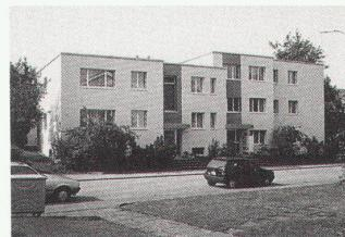
Durch die Plattengröße von maximal 1195x3500 mm können überflüssige Fugenbildungen vermieden werden. Fertig vorgefertigte Eckstücke, am Bau hergestellte Eckausbildungen oder entsprechende Fassadenprofile gewährleisten einen optimalen Anschluss bei Leibungen, Ecken, Fenstern und Türen usw. Die Montage erfolgt auf einer Holz- oder Aluminiumunterkonstruktion.
