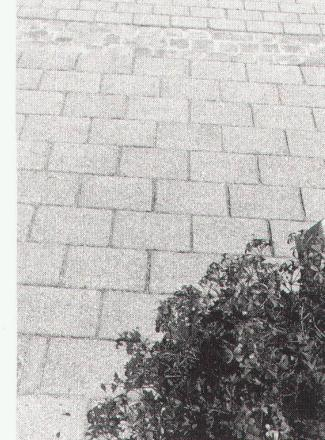
durch diverse Vorteile für Planer und Ausführende. Dazu zählen die für alle Verkehrsbelastungen geeignete Steinstärke, die integrierten Abstandnöcken, 2 Formate und die verschiedenen Möglichkeiten der Farbgebung.
