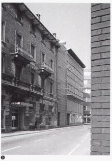
Das Gebäude setzt sich aus zwei von der Konstruktion her unterschiedlichen Teilen zusammen: aus einem inneren, bestehend aus dem tragenden Skelett mit dem Erschliessungskern, den Nasszellen und den Nutzflächen, und einem äusseren, bestehend aus einer den inneren Organismus schützenden Hülle.
