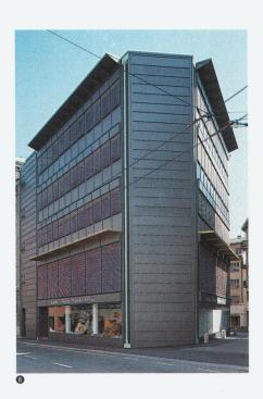
delt sich um einen opaken, leicht rauhen Zweikomponentenlack, der Eisenglimmer enthält. So behandelt, erinnern die Fassaden an jene der früher im Tessin realisierten Eisen- und Gusseisenbauten.
