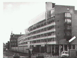
Wohngebäude Droogbak, Amsterdam, 1986–89, Architekt: Rudy Uytendaele
