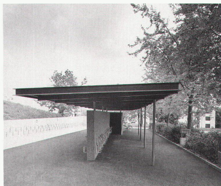
7 Ansicht Velounterstand / Vue de l'abri pour vélos / View of the bike shelter
