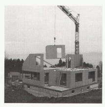
Aus Nadelholzspänen und in formaldehydfreier Verleimung hergestellt ist HOMOGEN 80 ein Baustoff mit allen guten Eigenschaften von Holz: tragfähig, schlagfest, stabil, wärmedämmend, dauerhaft und leicht verarbeitbar. Die Wandelemente sorgen für gesundes Raumklima und für kurze Gesamtbauzeit. Weil sie atmungsaktiv sind und montagefertig geliefert werden. HOMOGEN 80 bringt den Fortschritt in ausgereifter Holztechnik. Rufen Sie uns an und verlangen Sie unsere Unterlagen.
