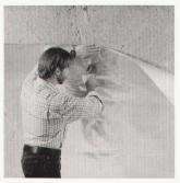
Die von der Korff AG entwikkelte Universal-Dachsperre Super garantiert neben einer hohen mechanischen Reissfestigkeit eine absolute Dampfdichtigkeit (wasserdampfdifusionsäquivalente Luftschichtdicke  $S_d = 2824 \text{ m}$ ).
