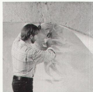
Die von der Korff AG entwickelte Universal-Dachsperre Super garantiert neben einer hohen mechanischen Reissfestigkeit eine absolute Dampfdichtigkeit (wasser dampfdiffusionsäquivalente Luftschichtdicke S<sub>d</sub> = 2824 m).
