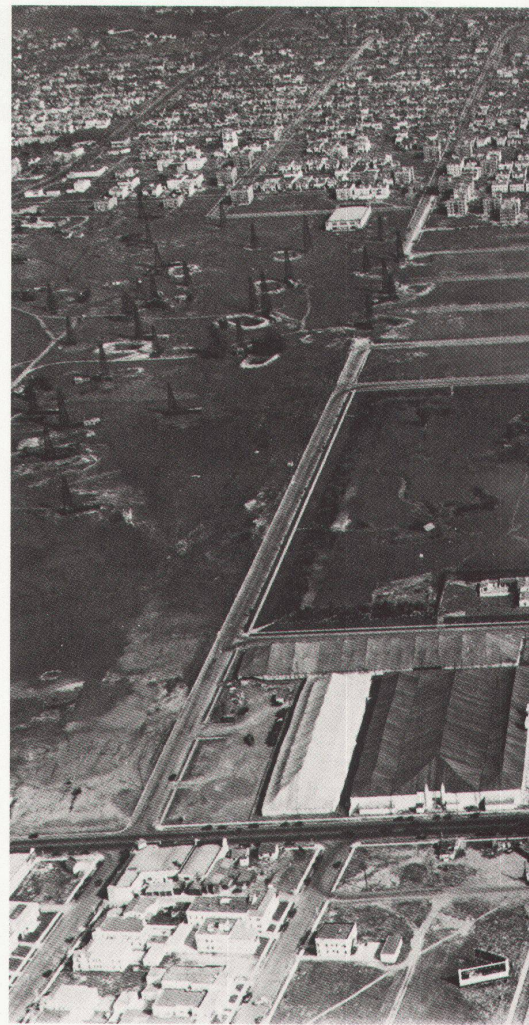
7 Wilshire Boulevard 1930 (aus: David Gebhard, Harriette von Breton, «L.A. in the Thirties», Los Angeles 1975)
