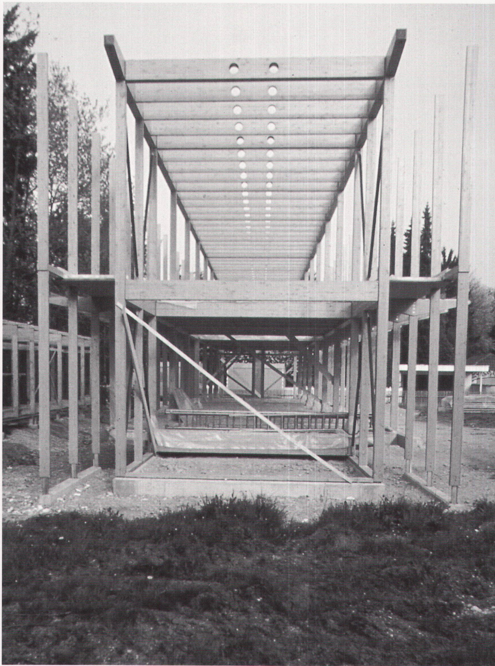
7 8 Montage der Holzkonstruktion
