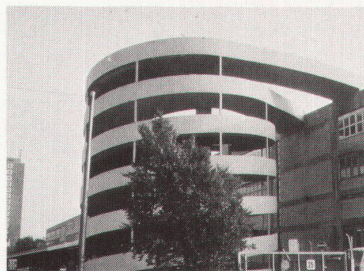
Rampe Parkhaus Migros Herdern
