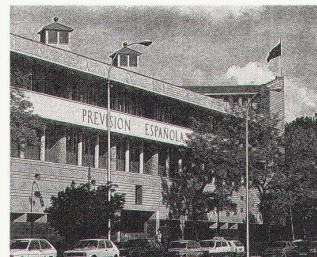
Das Versicherungsgebäude «Prevision Española» in Sevilla (Arch. R. Moneo)
