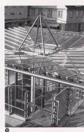
Mit dem Prinzip «Bolzen und Lasche» werden über Knotenbleche alle auftretenden Kräfte visuell nachvollziehbar zusammengeführt.
