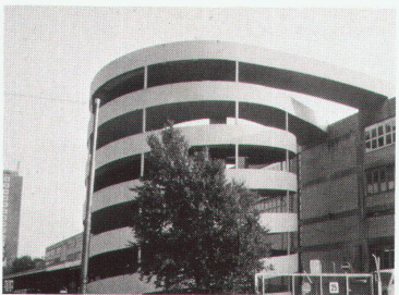
Rampe Parkhaus Migros Herdern
