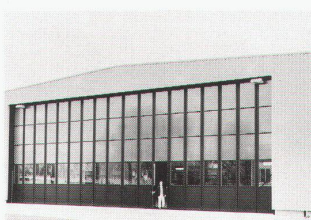
Hangartor 21×7,5 m, Limes AG, Kloten
