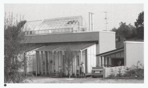
Etwa ein Drittel der Dachfläche ist als offene Dachterrasse ausgeführt, daran angrenzend wurde auf der Brüstung ein vielfältig nutzbares Glashaus montiert. Die Lamellen des Glasdaches lassen sich mit Hilfe eines Elektromotors öffnen, der auch in Abwesenheit der Bewohner mittels einer Schaltuhr die Belüftung reguliert. An den Montageschienen in den Längsseiten des Gebäudekerns werden die Pavillons befestigt. Sie können bis zu einer maximalen Tiefe von 540 cm individuell gestaltet werden.
