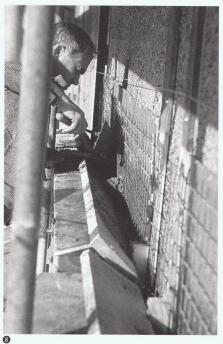
Montage der 6 cm dicken neuen Betonschicht / Mise en place d'une couche de 6 cm de béton frais / Applying the 6 cm thick, new coating of concrete
