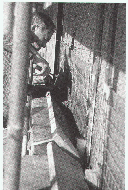
8 Montage der 6 cm dicken neuen Betonschicht / Mise en place d'une couche de 6 cm de béton frais / Applying the 6 cm thick, new coating of concrete
