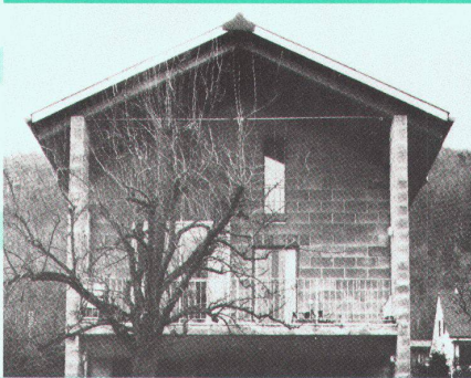
Michael Alder Wohnhaus Rodersdorf
