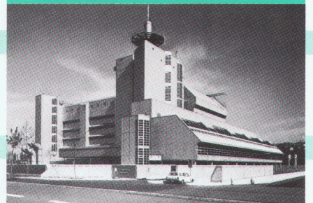
Theo Hotz Fernmeldebetriebszentrum Zürich
