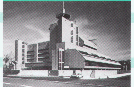
Theo Hotz Fernmeldebetriebszentrum Zürich
