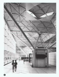
Um dem Flughafen zur grösstmöglichen Flexibilität hinsichtlich späterer Änderungen und Modifikationen zu verhelfen, wurden alle Passagiereinrichtungen auf der Ebene der Flughafenhalle als freistehende Elemente entworfen, die leicht neu angeordnet werden können.
