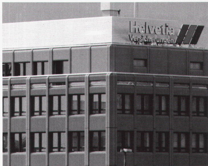
Geschäftshaus Helvetia-Unfall Zürich
