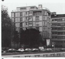
menten verkleidet, deren Färbung an die Molasse der Gesimse und Eckeinfassungen der Gebäude an der Uferstrasse erinnert. Die flachen, nicht tragenden Teile der Fassaden sind mit farbigen Steinplatten aus Hauterive verkleidet, die der Farbe des Putzes der angrenzenden Gebäude ähneln. Die Fenster bestehen aus Holz und einbrennlackiertem Aluminium, ebenso die Jalousien, die Einfassungen und die Wasserschenkel.
