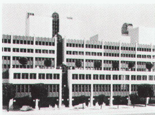
Das Ambassador House mit dem bewährten SponagelSystem der vorgehängten, hinterlüfteten Keramikfassaden.
