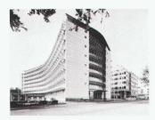
In der raumabschliessenden Ebene besteht die Fassade aus mehrschichtigen isolierten Brüstungspaneelen mit dazwischengesetzten Fensterelementen vom Typ IS-70 der Ernst Schweizer AG.
