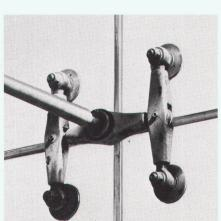
bildet ein eigenes System, an das die mit Löchern versehenen Scheiben angehängt sind. Die architektonische Idee entspricht einer ebenen «schwebenden» Fassadenhaut. Die Gläser sind nicht in Rahmen gefasst, sondern – fast unsichtbar – punktuell, an «Schmetterlingsknoten, befestigt. Damit soll die Trennung der tragenden Teile und der raumbegrenzenden Hülle, also die Schichtung der verschiedenen konstruktiven Elemente, eine formale Entsprechung erhalten.
