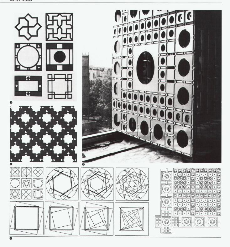
Die Technik der Blende als sonnenschützendes Fassaden-element / La technique du diaphragme appliquée à l'élé-ment de protection solaire d'une façade / Shutter technique for sun protection: an element of the façade
