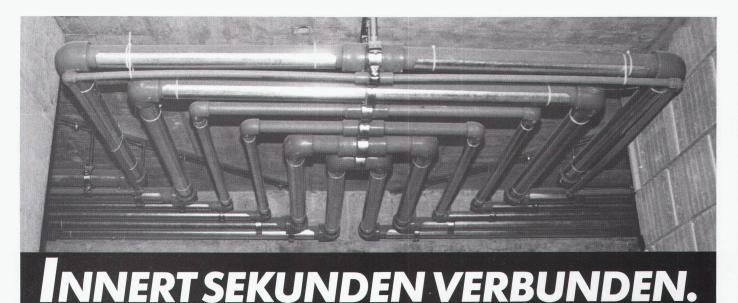
Das Unisan Installations-System ist einzigartig in der Schweiz. Die sichere und einfache Schweisstechnik verbindet alle Rohr- und Formstücke innert Sekunden, was eine rationelle und wirtschaftliche Montage ermöglicht. Durch die ausschliessliche Verwendung von Vollkunststoff verhindert das Unisan-System jegliche Korrosion bei Heizungs- und Sanitärinstallationen. Unisan hat sich im Neu- und Renovationsbau bestens bewährt. Verlangen Sie unsere Referenzliste sowie die ausführlichen Unterlagen.
