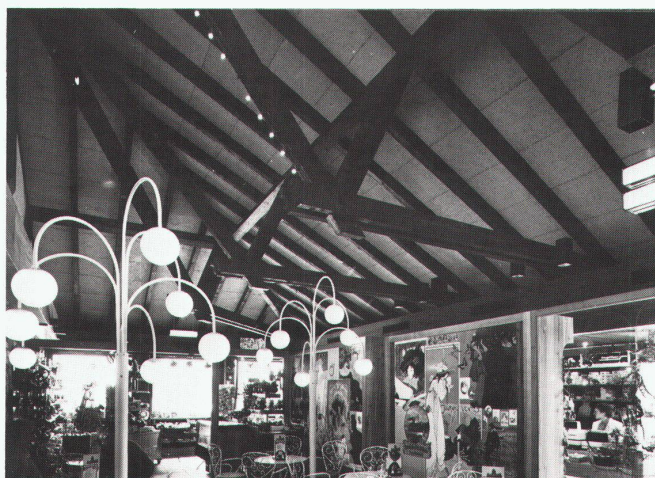
Autobahnrestaurant Mövenpick in Yverne-Aigle VD: 1200 m 2 Schichtex-Spezial 75/III, in Speziallängen, mit Längsfalz und Strukturanstrich, weiss gebrochen, auf Holzpfetten montiert.
