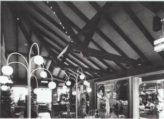
Autobahnrestaurant Mövenpick in Yvorne-Aigle VD:  $1200~\rm m^2$  Schichtex-Spezial  $75/\rm III$ , in Speziallängen, mit Längsfalz und Strukturanstrich, weiss gebrochen, auf Holzpfetten mon-
