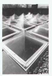
lendicke. Um eine 100%ige Isolierung und Dichtheit zu erreichen, wird auf eine billige Durchbohrung der einzelnen Schalen verzichtet.
