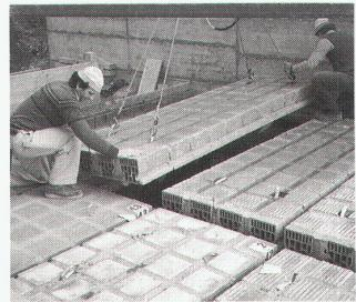
anzubringen. Die Decke bietet einen hervorragenden Wärmeschutz, da die Deckenziegel aufgrund ihrer geringen Rohdichte und der über den Querschnitt verteilten Lochkanäle einen hohen Wärmeschutzwiderstand aufweisen. Sie ist für Räume mit hoher Luftfeuchtigkeit besonders geeignet, da das Ziegelmaterial Schwitzwasserbildung vermeidet. Bricomat AG, 8048 Zürich
