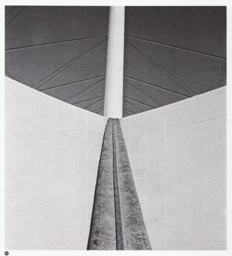
tragen die Fasern die auf die Membranfläche wirkenden Kräfte ausschliesslich als Zugkräfte auf die Radial- und Randseile; die Beschichtung schützt die Faser vor Zerstörung durch mechanischen Abrieb, Wärme und Feuchtigkeit (Glas kann durch die kombinierte Wirkung von Feuchtigkeit und Wärme im Laufe der Zeit zerstört werden).
