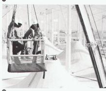
Verbindung Seil/Membrane flexibel gehalten, das Seil verläuft lose in einer Membrantasche.
