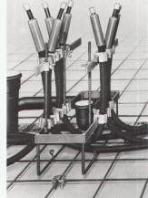
Der Montagerahmen ist wesentlich vereinfacht worden. Es werden keine Stützen mehr in die Schalung eingeschlagen, sondern die schlittenartigen Standfüsse aus Rundstahl werden auf der unteren Armierung festgebunden. Dazu dienen die normalen, bauüblichen Drahtbinder. Der neue Montagerahmen ist deshalb
