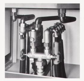
Plus 1: Die Absperrventile für Kalt- und Warmwasser mit dem Zuleitungsraccord sind jetzt aus einem Guss und für Wasser-Zuleitungen von links und von rechts geeignet.
