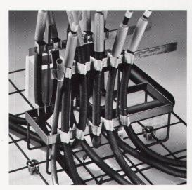
Plus 4: Der Montagerahmen des Instablocs wird jetzt bei dem domotec-quadro auf schlittenartigen Standfüssen aus Rundstahl direkt auf die untere Armierung gestellt und fixiert!
