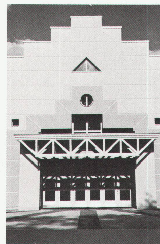
«Radio-Graffiti» à l'immeuble de Cesa, Estavayer-le-Lac. Architecte: Lucien Duran, Le Lignon, Maître d'état: OWL AG/Ray et Vichet SA, Givisiez FR
