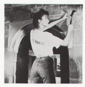
Die leichten Elemente, die vor allem in Renovationen eingesetzt werden, bilden als Rabitzgeflecht den optimalen Putzträger.
