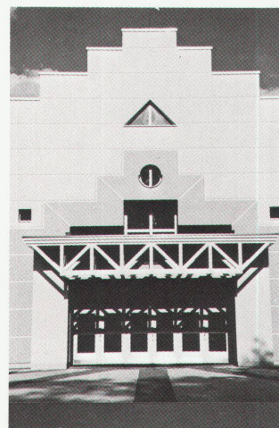
«Radio-Graffiti» à l'immeuble de Cesa, Estavayer-le-Lac. Architecte: Lucien Duran, Le Lignon, Maître d'état: OWL AG/Ray et Vichet SA, Givisiez FR
