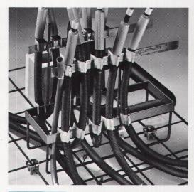
Der Montagerahmen des Instablocs wird jetzt bei dem domotec-quadro auf schlittenartigen Standfüssen aus Rundstahl direkt auf die untere Armierung gestellt und fixiert!
