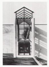
Richtig angewandt, eignen sich Schrägverglasungen vorzüglich zur Nutzung der passiven Sonnenenergie. Durch ein Zweifach-Isolierglas z.B. gelangen über 80% der in den Sonnenstrahlen enthaltenen Energie ins Rauminnere. Die eindringenden Strahlen vermögen Wände und Gegenstände aufzuwärmen, die dann wiederum Wärmestrahlen abgeben. Diese befinden sich jedoch in einem längeren Wellenbereich und können deshalb nicht mehr direkt durch die Verglasung nach aussen gelangen.
