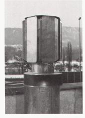
Geeignet überall, wo eine gleichmässige, wartungsfreie Dauerlüftung erwünscht ist. Ungeeignet für rasche Ableitung von temporär stark anfallendem Dampf oder Qualm. Dichtheit garantiert gegen Regen und Schnee, rückstausicher.
