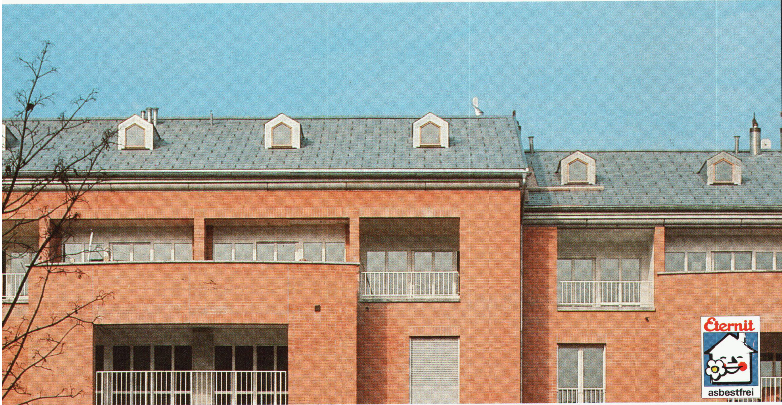
Mehrfamilienhaus «Habitat», 8957 Spreitenbach. Architekt Urs Fischbacher, Dachdecker P. Wiederkehr
