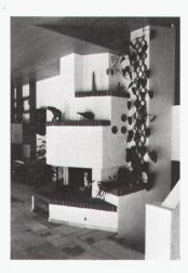
Frei-Cheminées nutzen die Wärmeenergie. Und zwar optimal. Das Heizsystem erreicht nämlich einen Wirkungsgrad bis zu 81%! Dies entspricht 16,6 kW oder 16000 kcal/Std. mit 5 kg trockenem Buchenoder Birkenholz. Aber auch schon der kleinste Einsatztyp hat einen beachtlichen Wirkungsgrad.
