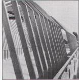
Die grazile Tragkonstruktion der 93 Meter langen, 12,2 Meter breiten und 9,1 Meter hohen Glaskuppel, die das Nützliche mit dem Schönen ideal verbindet, besteht aus 94 RHS-Profilen – jeden Meter eines. In je zwei Teilen in Würenlingen fabriziert, brauchten die Rahmen vor Ort nur noch verschraubt zu werden. Dabei erfüllte höchste Präzision die Erwartungen des auftraggebenden Glasbauers.
