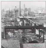
Sowohl Konstruktion als auch Montage der 150 Meter langen geschweissten Blechträger im Abstand von 26 Metern hatten sich verschiedenen Gegebenheiten anzupassen: den Gebäuden, Einrichtungen, Gruben, aber auch dem Betriebsablauf. Somit konnten gerade bei diesem nicht alltäglichen Projekt die Vorteile des Stahlbaus – Flexibilität, kleines Eigengewicht und kurze Bauzeit – bestens ausgeschöpft werden.
