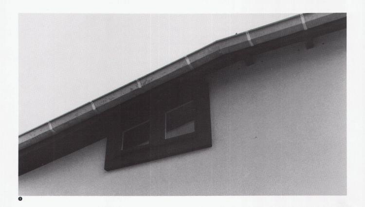
Fensterdetail der Nordfassade, braun bemalter, aufgesetzter Rahmen / Détail de fenêtre de la façade nord, cadre appliqué peint en brun / Detail of a north façade window: superimposed frame, painted brown
