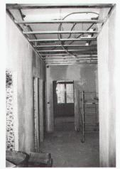
Überhohe Decken in Althäusern lassen sich mit einer abgehängten Knauf-Decke aus Metallprofilen und Bauplatten GK korrigieren. Im Hohlraum lässt sich so manche vertikal geführte Leitung verstauen.
