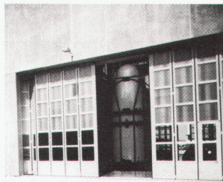
Ariane-Raketenspitze in der Montagehalle in Emmen, geschützt durch zwei 16flügelige Riesentore von je 5 Tonnen
