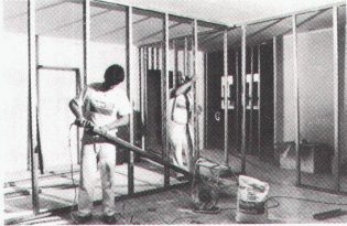
Montage der Metallständer-Unterkonstruktion.
