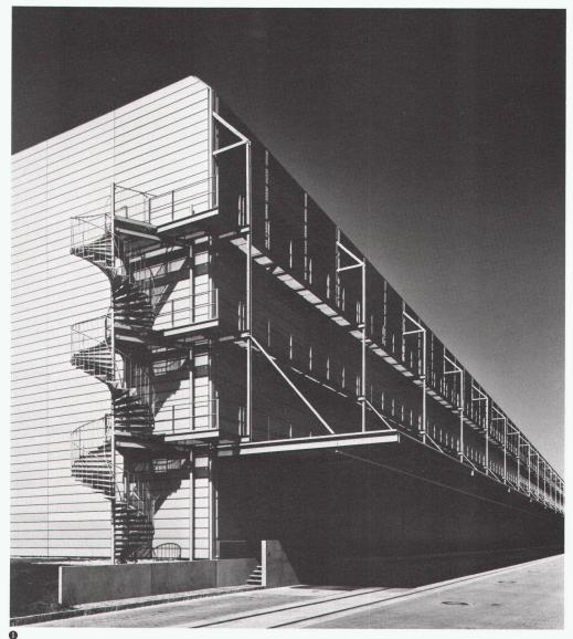
macht so den Sachverhalt, dass sie vor der tragenden Konstruktion hängt, deutlich.
