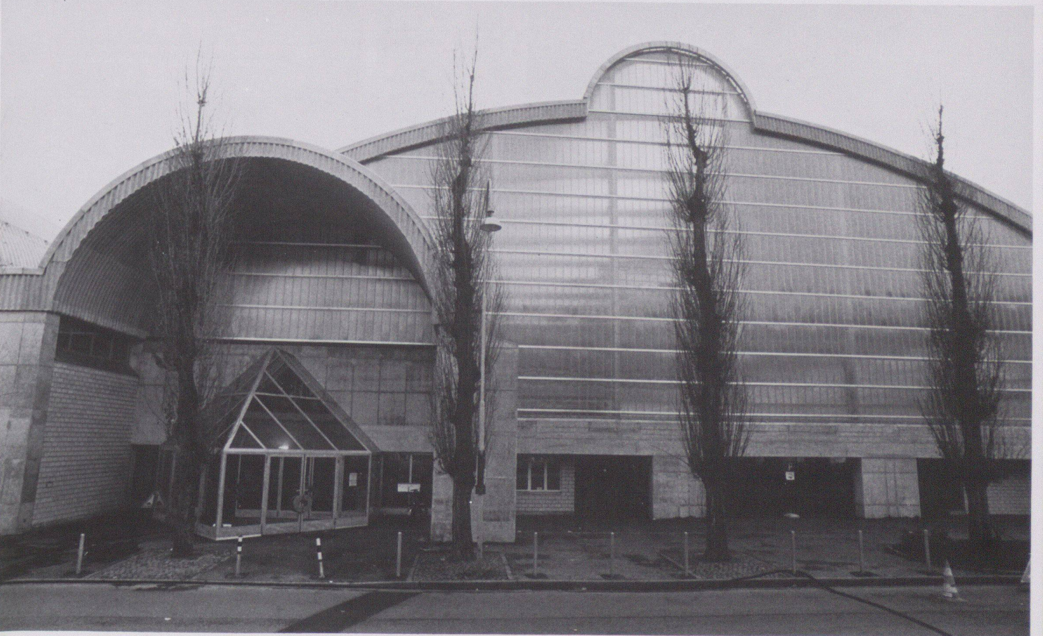
① Gesamtansicht von Südosten
