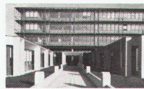
Bâtiment de Biologie, Lausanne-Dorigny 02.07 Universitäten Heft Nr. 7/8, 1984 Architekt: Fonso Boschetti, Epalinges
