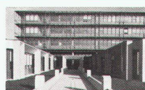
Bâtiment de Biologie, Lausanne-Dorigny 02.07 Universitäten Heft Nr. 7/8, 1984 Architekt: Fonso Boschetti, Epalinges
