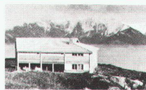
Alpbetrieb Sogn Carli, Morissen (Lugnez GR) 04.04 Landwirtschaftliche Produktionsanlagen Heft Nr. 3/1983 Architekt: W. Christen, Zürich
