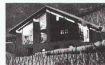
Habitation, transformation d'une maison rurale, Valençon 01.07 Einfamilienhäuser Heft Nr. 12/1982 Architekt: M. Zufferey, Sierre
