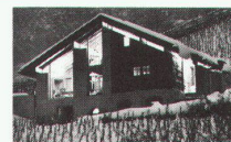
Habitation, transformation d'une maison rurale, Valençon 01.07 Einfamilienhäuser Heft Nr. 12/1982 Architekt: M. Zufferey, Siere
